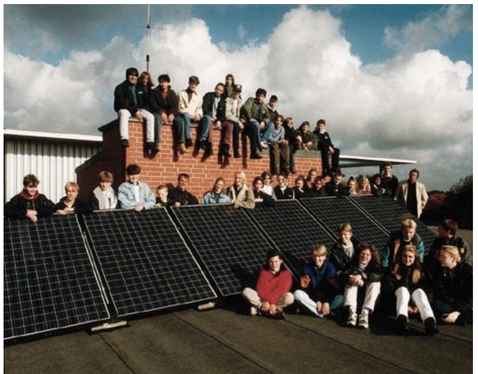
Die erste Photovoltaik-Anlage nach der Fertigstellung 1996. Foto: Stadtteilschule Blankenese
